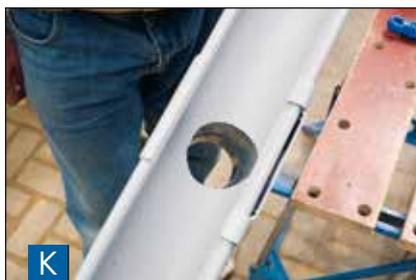
С отрезанной кромки удалить заусенцы и навесить воронку желоба на заднюю отбортовку и защелкнуть за передний валик.
