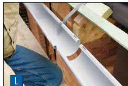
Желоба соединяются с помощью соединительной подкладки. Правильное расстояние между концами желобов получается из маркировок на соединительной подкладке.
