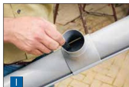
**I** Надеть воронку, определить точное место для слива и отметить выемку для слива воды.
