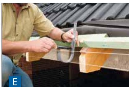
**E** Остальные опоры желоба выставить по этому строительному шнуру, определить размер для для отгибания отдельных опор желоба и отметить на опорах желоба.
