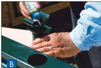
**B** Воронку желоба на внутренней стороне желоб на участке склеивания на внешней стороне очистить чистящим средством Marley для водосточных желобов и обезжирить. Затем нанести клей на внутреннюю сторону воронки.
