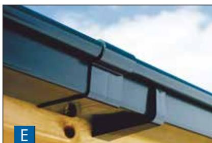
**E** При соединении 2 концов желобов необходимо использовать соединительную подкладку. Нанести клей на внутреннюю сторону соединительной подкладки и вдвинуть концы желобов в соединительную подкладку.
