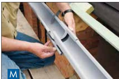
Соединительная подкладка сначала надевается на заднюю сторону соединяемых желобов, затем нащёлкивается её передняя часть на желоба. Учитывайте маркировку - система выступ-паз
