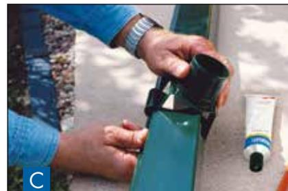
**C** После нанесения клея на воронку желоба сразу же соединить детали. Для этого воронку желоба навесить на заднюю отбортовку и защелкнуть за передний валик.
