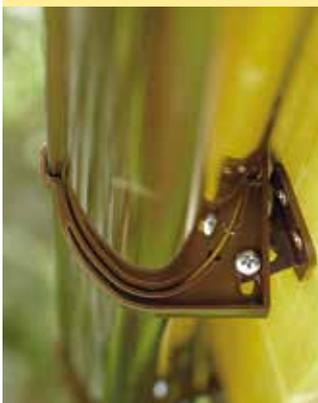
Делается так: регулируемые опоры желоба Marley Вы сначала привинчиваете, а потом настраиваете наклон и уклон. Это существенно облегчает установку. При монтаже на ветровой доске опора для желоба компенсирует наклон до 25°. Максимальное расстояние: расстояние между кронштейнами для желобов Duplex макс. 40 см!
