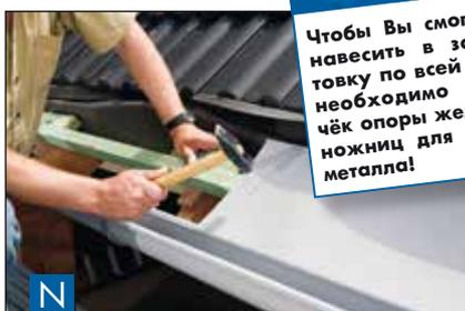
Капельники обеспечивают дополнительную защиту от дождевой воды и заносимого снега. Они навешиваются в отбортовку водосточного желоба и крепятся кровельными винтами к рейке обрешетки.
