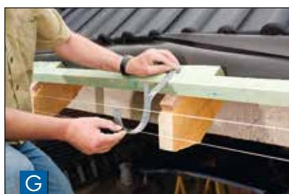
**G** Закрепить отогнутые опоры желоба в углублениях на рейке обрешетки с помощью самонарезающих винтов или соответствующих гвоздей.
