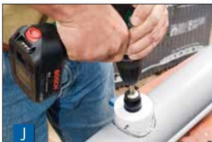
Выпиливание сливного отверстия проходит быстро и чисто с помощью кольцевого сверла-насадки или с помощью пилы с мелким зубом.
