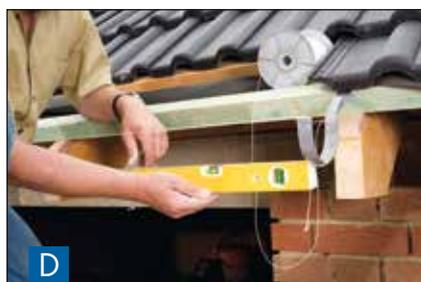
**D** Еще раз проверить на строительном шнуре уклон, на 10 м водосточного желоба необходимо заложить 2 - 3 см уклона.
