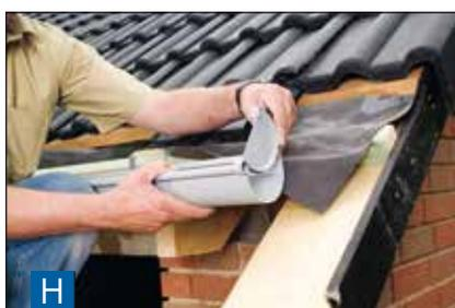
**H** Отрезать водосточный желоб с помощью ножовки подходящей длины и уложить на опоры желоба. Заглушка просто надевается.
